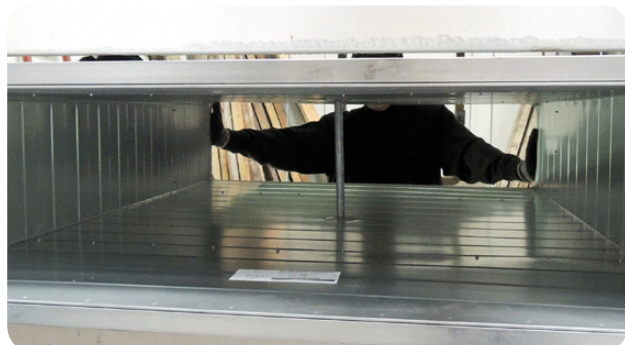
Obr. 38 Výztužení segmentu potrubí uprostřed rozpětí
