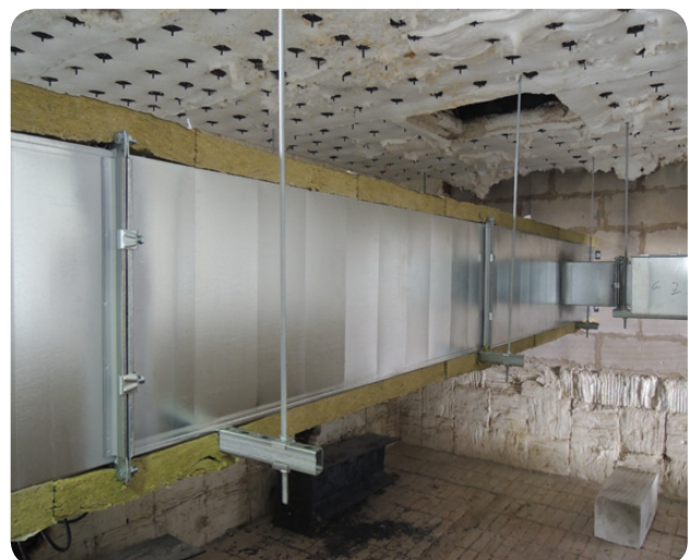
Obr. 29 Standardní jednovrstvé kladení izolace v místě přírub
