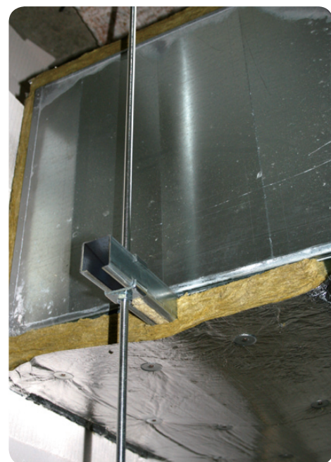
Obr. 20 Izolování instalačního profilu výšky 40 mm izolační tloušťky 40 mm
