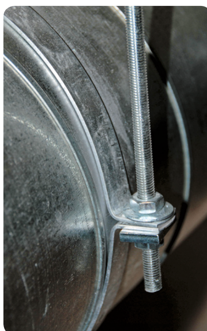
Obr. 32 Detail dvoudílné objímky pro zavěšení kruhového potrubí
