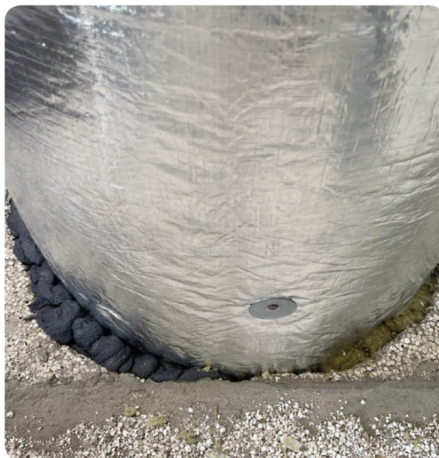
Obr. 37 Prostup bezpečnostním blokem (3i-isolet)
