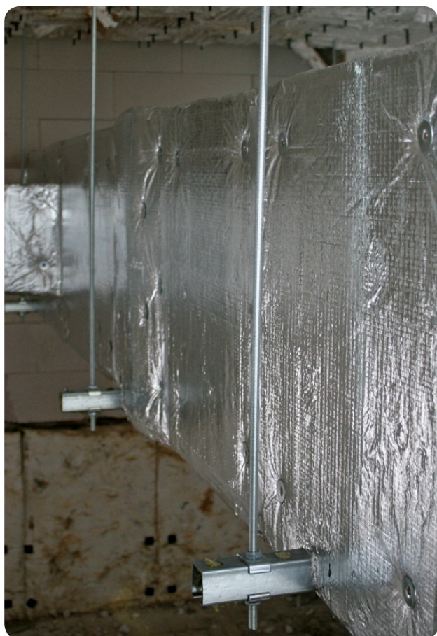
Obr. 21 Zavěšení potrubí závitovými tyčemi a instalačními profily. Na obrázku závitové tyče umístěny vně izolace (část instalačního profilu vyčnívajícího z izolace se v tomto případě neizoluje).
